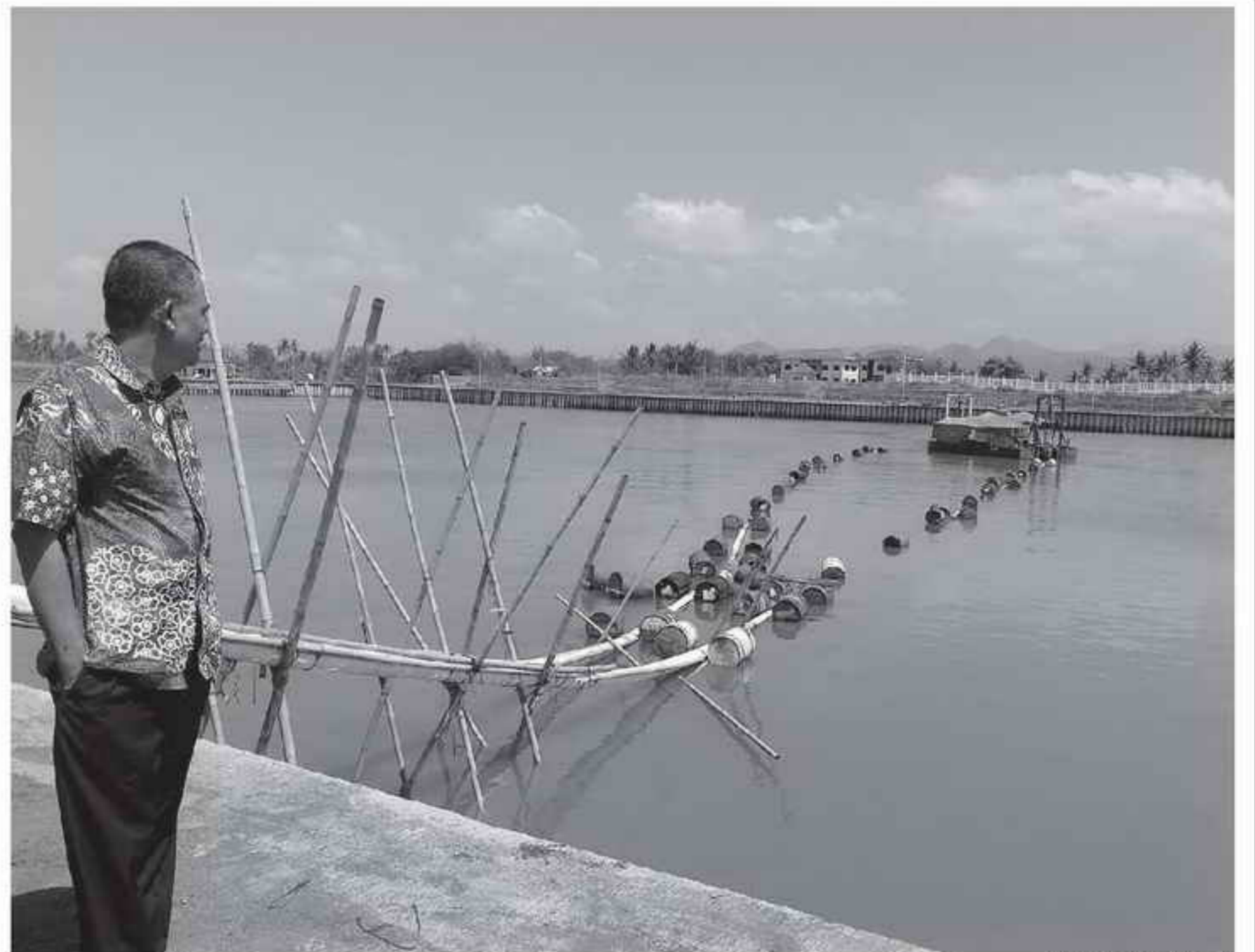
INSPEKSI - Anggota komis B DPRD DIY saat melakukan inspeksi di lokasi kolam Pelabuhan Tanjung Adikarto di Kulonprogo, Senin (16/11).
